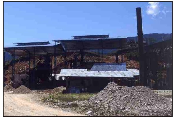
Planta de procesamiento de aceite de palma (en construcción). Aguaytía
